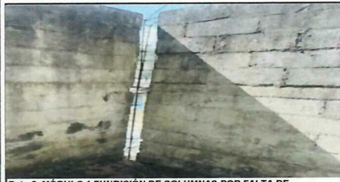
Foto 5: MÓDULO 1 FUNDICIÓN DE COLUMNAS POR FALTA DE RECURSOS
