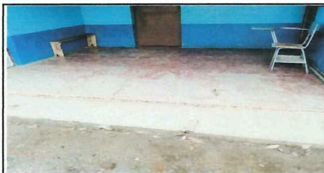
Foto 4: MÓDULO 4 CAMBIO DE PISO EN CORREDOR DEBIDO AL DETERIORO
