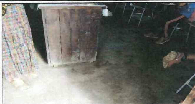
Foto 1: MÓDULO 1 CAMBIO DE PISO AULA POR DETERIORO
