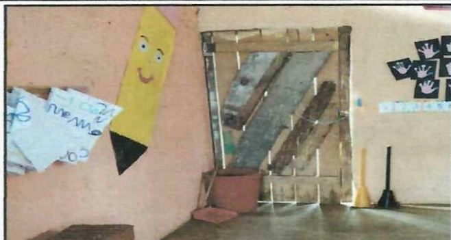
Foto 1: MÓDULO 3 CAMBIO DE PUERTA DE MADERA A UNA PUERTA DE METAL
