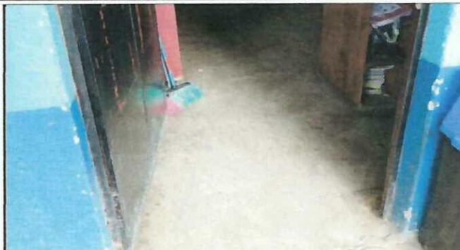
Foto 2: MÓDULO 1 CAMBIO DE PISO AULA POR DETERIORO
