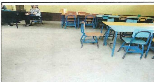
Foto 3: MÓDULO 4 AULA 1 CAMBIO DE PISO DEBIDO AL DETERIORO
